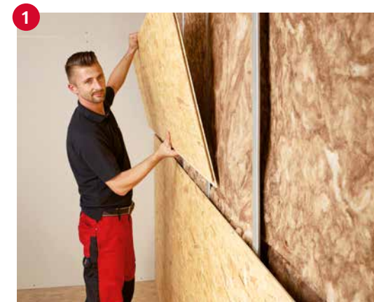
1 Läg in Ergo Board med stegspåret på längssidan. För att de olika kantprofilerna skall finnas i den rätta positionen skall märkningen på ovansidan vara läsbar från nere / vänster till uppe / höger.
