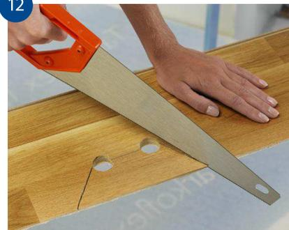
Om brädans långsida möter ett rör: borra ett hål med en diameter som är minst 16 mm större än rördiametern, så att det finns en rörelsefog runt röret. Markera med en blyertsenna var du ska såga. Såga av den bit som ska sitta bakom röret, närmast väggen. Snedsåga som bilden visar. Om rören är belägna vid golvet kortsida ska du kapa brädan i 90° vinkel rakt genom hålen.
