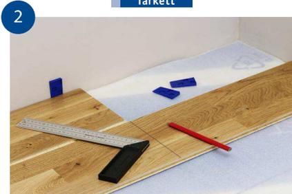
2 Vid slutet av raden, vänd sista brädan så att fjäder ligger mot fjäder. Skjut kortändan tätt mot väggen. Markerakapsnittet med en penna, 8-10 mm från föregående brädas kortända, så får du en rörelsefog när brädan sedan skjuts på plats.
