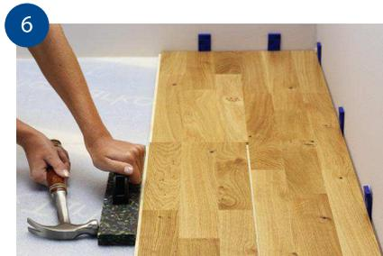
6 Tips: Vid långa brädrader är det svårt att ha kilarna monterade redan efter första raden. Vänta därför tills dess att 4-5 rader lagts, använd Tarktool och skjut det lagda flaket en bit från väggen och montera sedan kilarna.
