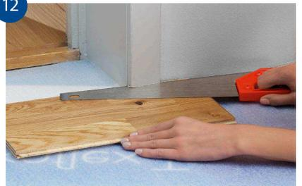
Dörrfoder kan man ta av och flytta upp, men det är oftast enklare att såga av dem. Använd en lös golvbräda som höjdmall och såga fodret med en fintandad såg. Skjut in golvet under fodret. Se till att golvet inte kläms mellan underlaget och foder. Komplettera med Tarketts lister.
