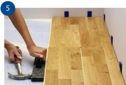
5 Viva slås först samman i långsidan, därefter kortändan. Använd Tarketts slagkloss när brädorna slås samman. Använd aldrig en avkapad brädbit som slagkloss. Detta och/eller för hård sammanslagning orsakar flisiga kanter.
