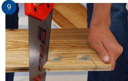
9 Såga av den bit som ska sitta bakom röret, närmast väggen. Snedsåga så som visas på bilden. Om röret är beläget vid golvet kortsida, kapas brädan i 90° vinkel rakt genom hålen.
