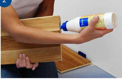
Limma noten på nästa brädas kortsida med Tarkett Parkettlim D3. Slå fast brädorna med hjälp av en slagkloss. Överflödigt lim torkas bort med en fuktig trasa.
