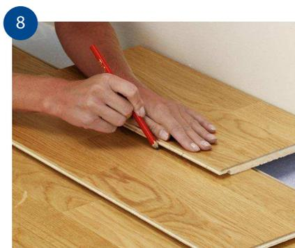
8 Sista raden: När du kommer till sista raden kan det hända att brädorna inte passar på bredden. Lägg i så fall den sista brädan med notsidan mot väggen, ovanpå och kant i kant med den näst sista brädan. Placera en extra brädbit ovanpå och mät mellanrummet genom att dra brädbiten längs väggen och markera med en blyertspenna där den sista brädan ska kapas. Om den sista brädraden inte har kapats måste den utstickande läppen sågas av för att en rörelsefog ska bibehållas.
