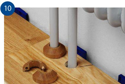
10 Slå brädan på plats, limma fast den lösa biten, kila mot vägg och täck med rörmanschetter.
