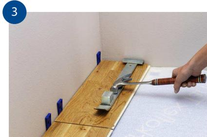
3 Kapa därefter brädan, skjut in brädan på plats, slå samman med Tarktool slagjärn och sätt dit en kil vid kortändan mot väggen.
