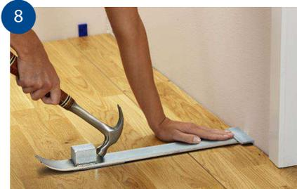
8 Slå in den avsågade brädan med hjälp av slagjärnet. Om sista brädraden ej har kapats, måste fjädern sågas bort, så att inte rörelsefogen försvinner.
