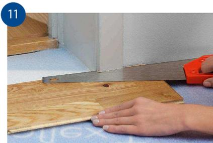
11 Dörrfoder kan man ta av och flytta upp, men det är oftast enklare att såga av dem. Använd en lös golvbräda som höjdmall och såga fodret med en fintandad såg. Skjut in golvet under fodret. Se till att golvet inte kläms mellan underlaget och foder. Komplettera med Tarketts lister.
