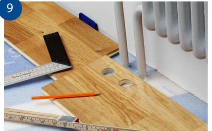
Om brädans långsida möter ett rör: borra ett hål med en diameter som är minst 16 mm större än rördiametern, så att det finns en rörelsefog runt röret. Markera med en blyertspenna var du ska såga.
