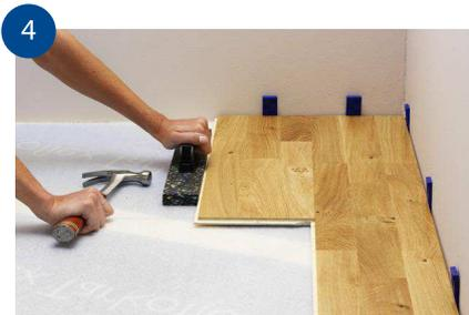
4 Börja andra brädraden med resten av den kapade brädan. Se också till att tvärskarvarna på den intilliggande raden överlappas med minst 50 cm, (<1250 mm långa brädor minst 30 cm). Fortsätt likadant med följande brädrader.
