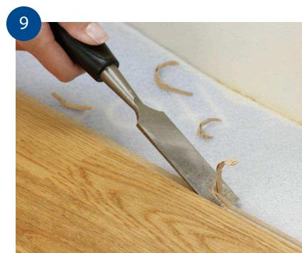
9 Om det inte finns tillräckligt med utrymme att vika ned den sista brädan kan den skjutas in från sidan istället. För att det ska vara möjligt måste den utstickande läppen på den föregående brädraden göras rak. Använd ett stämjärn för att skära av den del av läppen som skjuter ut som en kulle längst upp på ytterkanten.
