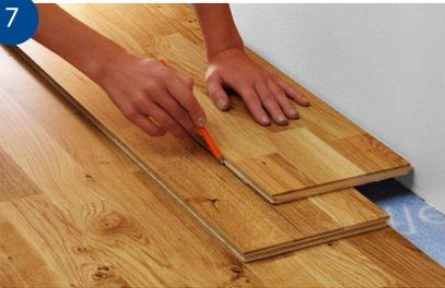
Sista brädraden behöver oftast kapas på längden. Lägg då sista brädan med fjädern mot väggen, rakt över och kant i kant med den näst sista brädraden. Lägg på en överbliven brädbit och mät upp avståndet genom att föra brädbiten längs med väggen, samtidigt som du markerar med en penna var du ska såga av sista brädan. Tag hänsyn till erforderlig rörelsefog.
