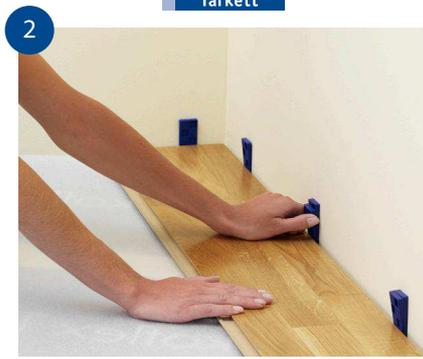
2 Första raden. Kom ihåg att golvbrädorna helst ska läggas i rummets längdriktning. Börja i ett vänsterhörn med fjädersidan mot väggen och arbeta åt höger. Tryck ned kilar mellan golvet och väggen för att skapa en rörelsefog på minst 8-10 mm.
