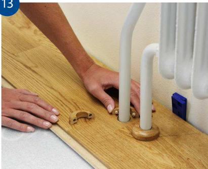
Slå brädan på plats, limma fast den lösa biten, lägg ett mellanlägg mot väggen och täck med rörmanschetter.
