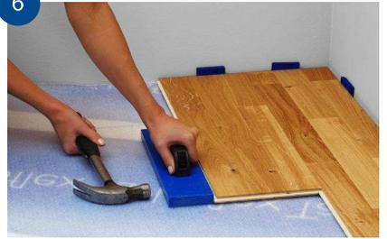
Använd Tarketts slagkloss när brädorna slås samman. Använd aldrig en avkapad brädbit som slagkloss. Tips: Vid långa brädrader är det svårt att ha brädkilarna monterade redan efter första raden. Vänta därför tills dess att 4-5 rader lagst, använd Tarktool och skjut det lagda flaket en bit från väggen och montera kilarna.
