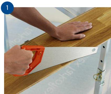
1 Innan du lägger den första raden måste du såga av den utskjutande delen på fjädersidan.
