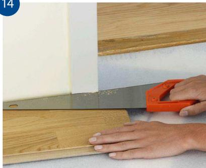
Dörrfoder kan tas av och flyttas upp, men det är oftast enklare att såga av dem. Använd en lösgolvbräda som höjdmall och såga av fodret. Se till att golvet inte kläms fast mellan undergolvet och karmen.
