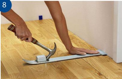
Slå in den avsågade brädan med hjälp av slagjärnet. Om sista brädraden ej har kapats, måste den utstickande läppen sågas av, så att inte rörelsefogen försvinner. Sätt kilar även vid sista brädraden. Låt kilarna sitta ett par timmar (t.ex. över natten) innan de avlägsnas.
