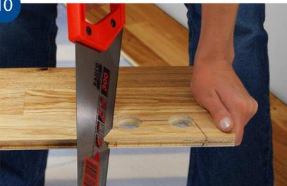
Såga av den bit som ska sitta bakom röret, närmast väggen. Snedsåga så som visas på bilden. Om röret är beläget vid golvet kortsida, kapas brädan i 90° vinkel rakt genom hålen.
