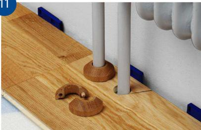
Slå brädan på plats, limma fast den lösa biten, kila mot vägg och täck med rörmanschetter.
