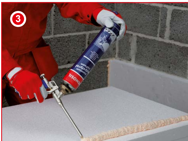
Levitä liimavaahto eristelevylle sivujen suuntaisesti (3-4 cm reunasta).
