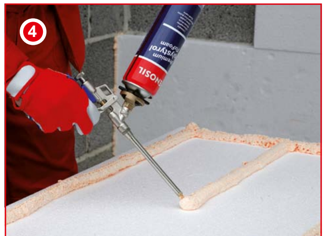
Lisäksi levitä yksi juova levyn keskelle pisimmän sivun suuntaisesti (liimaraitojen väli ~25 cm).
