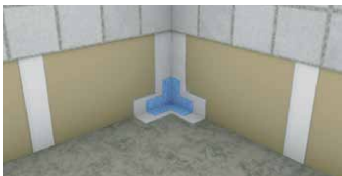
2. Leikkaa nurkkakappale vedeneristenuhasta 3627/3628 ja paina kiinni tuoreeseen eristeeseen. Käytettäessä valmiita WetStop PC/PC-e -nurkkakappaleita, kiinnitys tapahtuu SCHÖNOX iFIX -vedeneristeliimalla.
