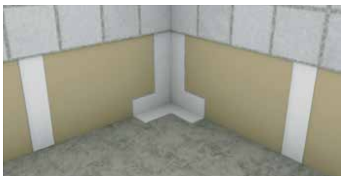
1. Levitä vedeneristettä nurkkakappaleen alueelle.
