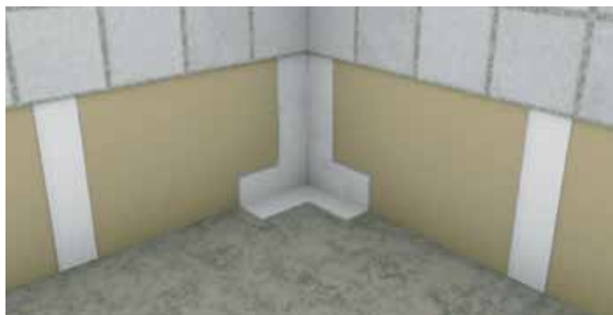
3. Vedeneristenuha 3627/3628 käsitellään SCHÖNOX HA / Casco AquaStop -vedeneristeellä.
