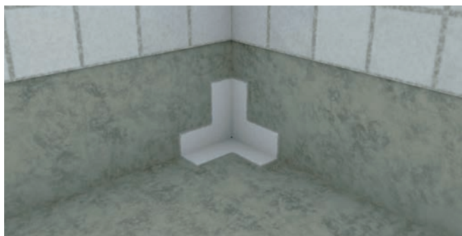
1. Levitä vedeneristettä nurkkakappaleen alueelle.
