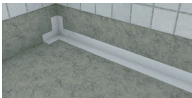
4. Taita vahvikenauha ja asenna se märkään vedeneristeeseen. Nurkkavahvikkeiden muoto kertoo suoraan tarvittavan limityksen määrän. Poista kaikki ilma vahvikkeiden alta ja tarkasta, että se on kastunut eristeeseen kauttaaltaan.
