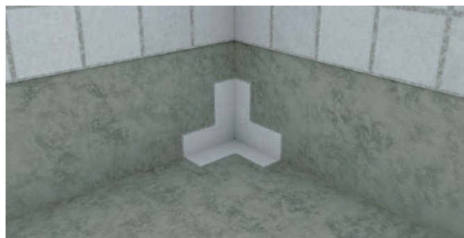
3. Levitä vedeneristettä nurkkakappaleen päälle.
