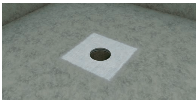
1. Poista kaivon kiristysrenkas, jätä vastatiiviste paikoilleen. Levitä SCHÖNOX HA /Casco AquaStop -vedeneristettä läpiviennin alueelle ohut kerros.
