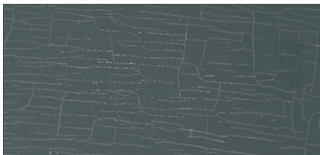
Materiaali on vaurioitunut UV-säteilystä johtuen.
