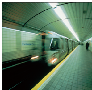
Käyttökohteita mm. tunnelit.
