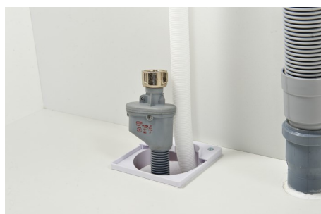
7. Tuo poisto- ja tuloletkut (magneettiventtiili) läpiviennin läpi
