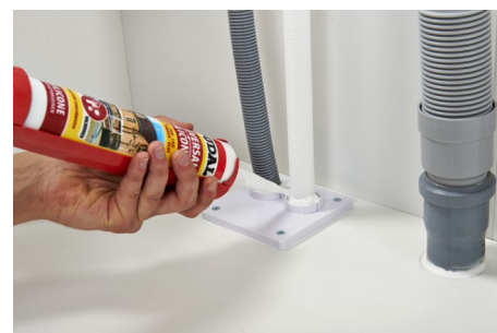
12. Kannakoi letkut sekä viimeistele ja tiivistä läpivienti huolellisesti silikonilla
