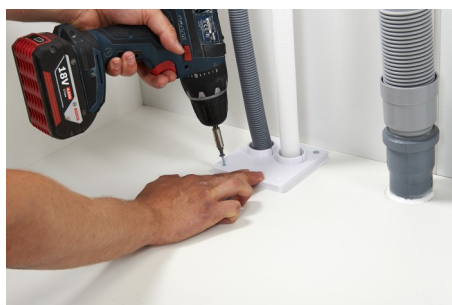
11. Ruuvaa suurempi kansi kiinni pohjan läpi pakkauksen ruuveilla
