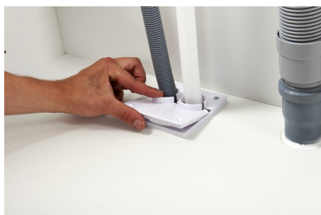
10. Aseta suurempi kansi 45° kulmassa paikoilleen
