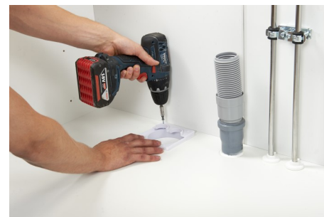
6. Ruuvaa pienempi kansi kiinni pohjan läpi pakkauksen ruuveilla
