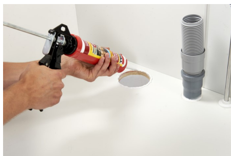
2. Laita silikonilla huolellisesti aukon ympärille
