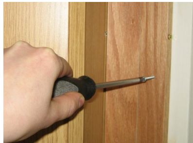
4. Työnnä ovi nippuun ja merkitse kiinnityspaneelin reuna ylä- ja alapäästä. Aukaise ovi ja kiinnitä paneeli ruuveilla (c)
