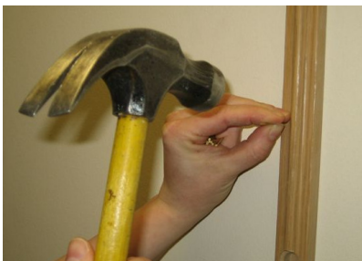
5. Kiinnitä lukkolistaa (D) nautoilla (d)
