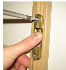
7. Kiinnitä lukkolevy (E) lukkolistaan ruuveilla karmiin tai seinään (a). Lukkolistan erivahvaisista seinämistä voi valita sen, joka toimii paremmin.
