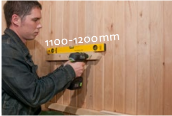
Mittaa kannatinten sijainti vatupassin avulla ja asenna. Ylempi laudekannatin kiinnitetään 3 ja alempi 4 ruuvilla.
