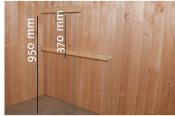
Paras sijaintipaikka istumalauteelle on katosta 1100-1200mm tai lattiasta 950mm. Kahden kannattimen suositeltava etäisyys on 370mm.
