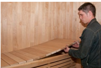
Asenna istumalaude rungon päälle.
