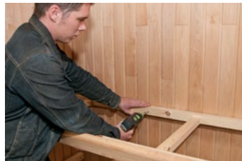
NB! Kiinnitä rakenne takaseinään kahdella ruuvilla. Sekä kannattimiin että rakenteeseen on asennettu vanerikaistale
