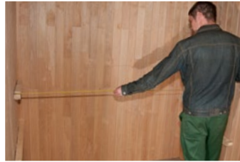
Mittaa seinien välinen etäisyys.
