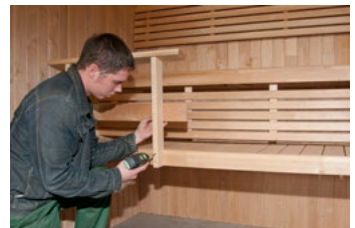
Kiuassuoja kiinnitetään lauteen etulautaan 4 ruuvilla.
