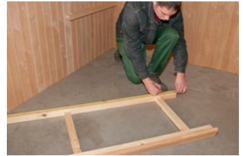
Leikkaa lauteen alusrakenne sopivan pituiseksi. NB! Lauteen runko voidaan leikata lyhyemmäksi enintään 100 mm verran alusrakenteen kummastakin päästä. Rungon muita osia ei saa muuttaa.
