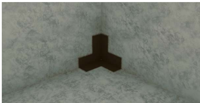
1. Levitä vedeneristettä nurkkakappaleen alueelle.
