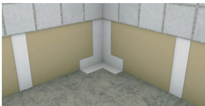
1. Levitä vedeneristettä nurkkakappaleen alueelle.
