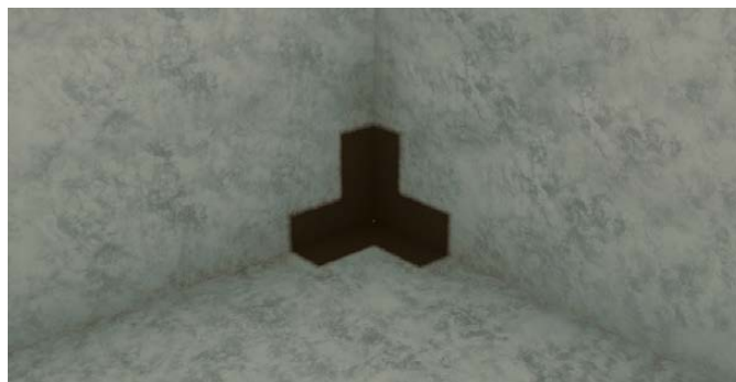
3. Levitä vedeneristettä nurkkakappaleen päälle.
