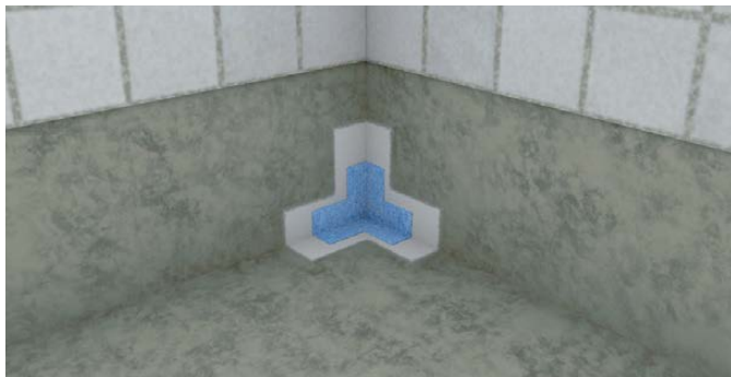
2. Paina Wetstop nurkkakappale kiinni tuoreeseen vedeneristeeseen siten, että kaikki ilma poistuu kappaleen alta. Jos nurkka ei ole täysin suorassa ja nurkkakappaleeseen syntyy pussi, pyri ohjaamaan pussi tulevan limityksen alueelle ja tee sinne viilto. Mikäli käytät vedeneristysnauhaa (kuitukangas), katso leikkausohjeet viereiseltä sivulta.
