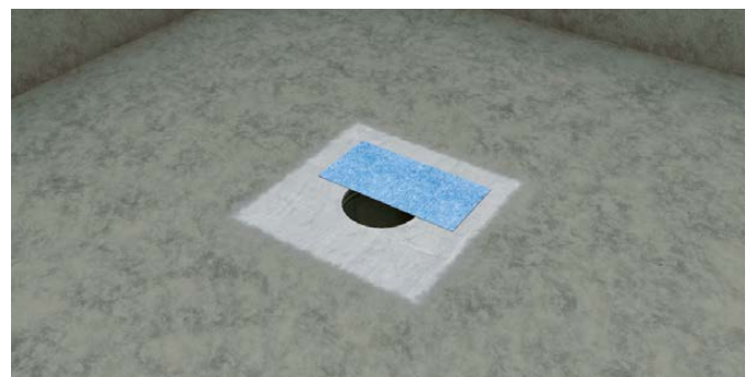
2. Poista toinen puoli läpivientikappaleen suojapaperista ja asemoi WetStop MG keskelle kaivoa.
