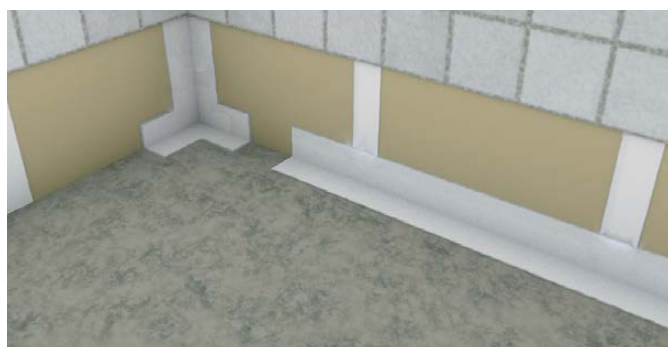
4. Levitä vedeneristettä vedeneristysnauhan alueelle lattian ja seinän liitoskohtaan.
