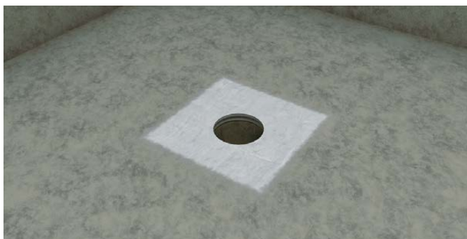
1. Poista kaivon kiristysrengas, jätä vastatiiviste paikoilleen. Levitä SCHÖNOX HA /Casco AquaStop -vedeneristettä läpiviennin alueelle ohut kerros.
