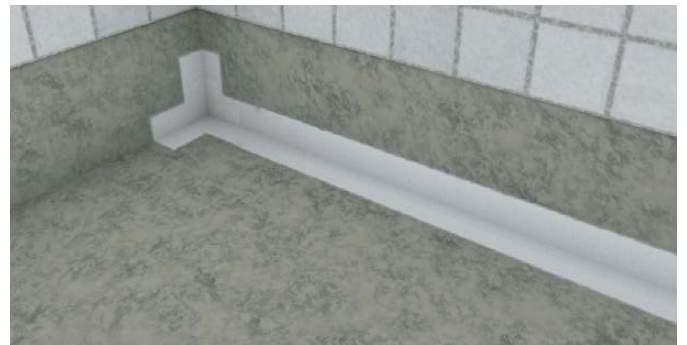
4. Taita vahvikenauha ja asenna se märkään vedeneristeeseen. Nurkkavahvikkeiden muoto kertoo suoraan tarvittavan limityksen määrän. Poista kaikki ilma vahvikkeiden alta ja tarkasta, että se on kastunut eristeeseen kauttaaltaan.
