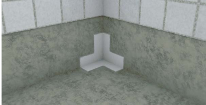
1. Levitä vedeneristettä nurkkakappaleen alueelle.
