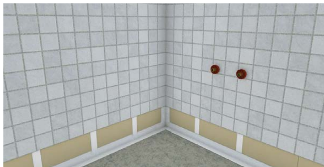
6. Jatka kunnes kaikki liitoskohdat on vahvennettu/tiivistetty.
