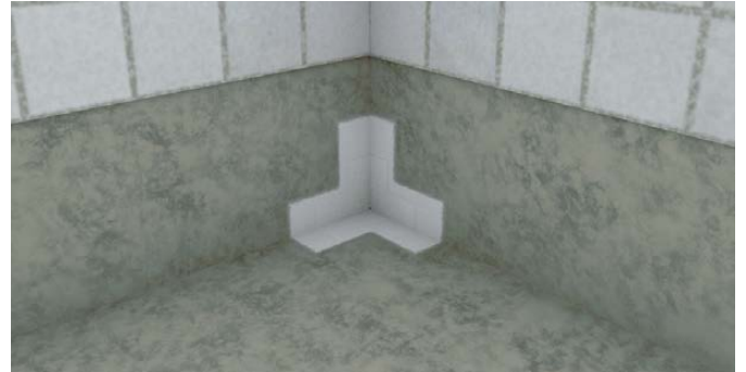
3. Levitä vedeneristettä nurkkakappaleen päälle.
