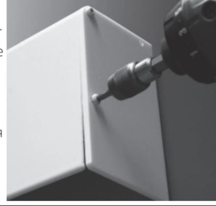
сторон торцевых заглушек. Закрепите торцевые заглушки находящимися в комплекте шурупами. Вам понадобится отвертка Torx 10.
