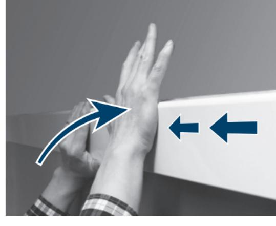
Varmista joka kohdassa erikseen, että **alempi** kiinnityskynsi on paikoillaan ennen kuin yrität painaa peitelevyä kiinni. Jos kisko ei ole suorassa, joudut käyttämään enemmän voimaa pitääksesi ylemmän kynnen kiinni kiskossa. Tarkista lopuksi, että peitelevy on kauttaaltaan paikoillaan, tömäytämällä sitä kämmensyrjällä kiinni kiskoon muutamasta kohdasta.
