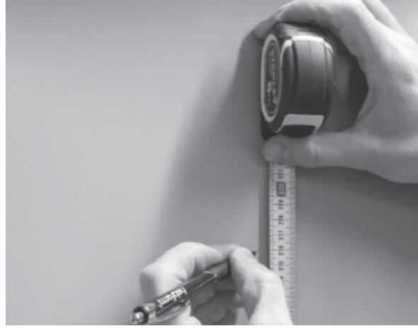
После того, как вы отметили одну точку, прочертите на стене с помощью ватерпаса горизонтальную линию на всем протяжении профиля. Так вы сможете отметить расположение крепежных шурупов всех кронштейнов.
