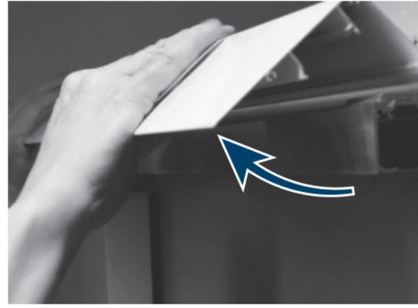
Внимание! Чтобы обеспечить лучшую опору при отгибании накладки, вы можете, например, вставить «деревянную палочку» толщиной около 10 мм внутрь профиля снизу так, чтобы она вошла в Т-образный паз крыши профиля. При снятии накладки держите палочку параллельно стене. Во избежание повреждения профиля не используйте твердый металл вместо деревянной палочки.
