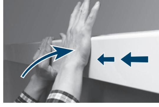
Прежде, чем нажать на накладку, проверяйте в каждом пункте отдельно, чтобы **нижний** крепежный зубец находился в правильном месте. Если профиль не расположен прямо, то вам придется приложить больше усилий, чтобы удержать верхний зубец в профиле. В конце проверьте, чтобы накладка была расположена по всей длине правильно, постучав ладонью по профилю в нескольких точках.
