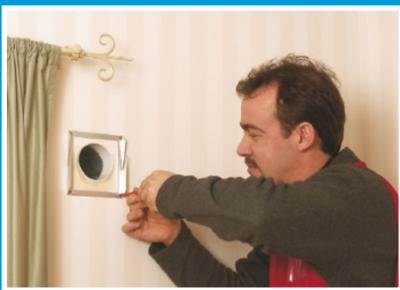
Efter att luftintagsröret och yttergallret installerats fästs installéringsramen på innerväggen. Om öppningen är större än anläggningen kan en underlagsskiva installeras.
