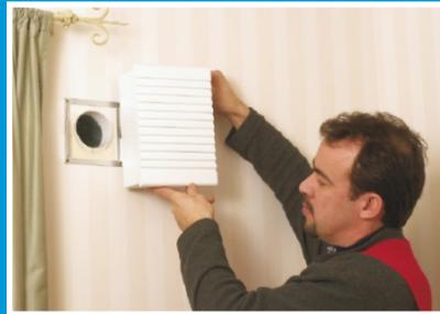
Laite painetaan kiinni asennuskehkyseen, jolloin se samalla tiivistyy seinäpintaa vasten, liitosta ulkoilmaputkeen ei tarvita. Sähkökytkentä voi olla kiinteä tai pistotulppakytkentä.
