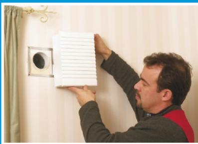
Intagsluftanläggningen trycks mot installéringsramen, där den samtidigt lägger sig tätt mot väggytan och ingen anslutning till luftintagsröret behövs. Elanslutning antingen fast eller med stickpropp.
