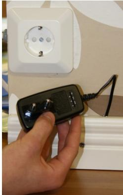
Virtalähteenä toimii 12V DC-muuntaja. Muuntajassa on säätmahdollisuus 4.5...12V. Liitosjohto muuntajalta koneeseen voidaan viedä seinärakenteen sisällä tai pinnassa esim. listan alla. Kojeessa on pikaliitin johon johto liitetään. Sähköistys on helppo tehdä vaikka itse. Johtoa ei saa taivuttaa liian jyrkälle mutkalle eikä sitä saa vahingoittaa asennuksen aikana
