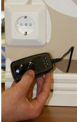
Strömkällan är en 12V DC-transformator. Transformatorn kan regleras mellan 4,5 – 12 V. Kabeln från transformatorn till anläggningen kan ledas innanför väggkonstruktionen eller på utsidan t ex under listan. Det finns en snabbkoppling för elkabeln. Elinstallationen är lätt att göra även på egen hand. Kabeln får inte böjas för mycket och den får inte skadas under installationen.
