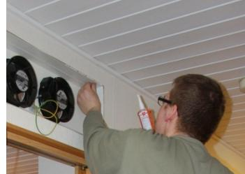
Efter att utrustningen är installerad i öppningen så tätas mellanrummet mellan väggelementet och genomföringskanalen. Med hjälp av genomföringskanalens teleskopdel justeras längden till väggens tjocklek – 10 mm. Luftriktningen skall vara mot det rum som skall värmas/avkylas. Om behovet är enbart för avkylning så nås bästa resultat då luftriktningen ställs utåt från rummet som skall avkylas.
