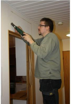
Oven yläpuolelle tehdään 550x215mm kokoinen aukko. Sen voi tehdä myös muualle kuin oven yläpuolelle, mutta mielellään seinän yläosaan.
