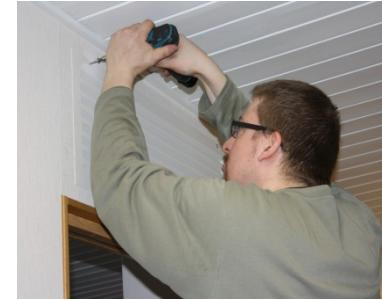
Säleiköt kiinnitetään paikoilleen ja asennus on valmis. Säleikkö asennetaan siten että ilmavirtaus on kattoon pään. Mikäli väliseinä ei pidetä auki, tulee väliseinän tai oveen asentaa siirtoilmasäleikkö.
