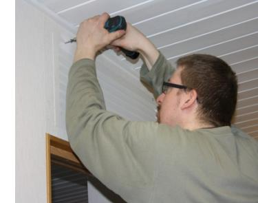
Gallret fästs på plats och installationen är färdig. Gallret installeras så att luftflödet riktas mot taket. Om innerdörren inte hålls öppen bör man installera ett luftgaller i mellanväggen eller i dörren.
