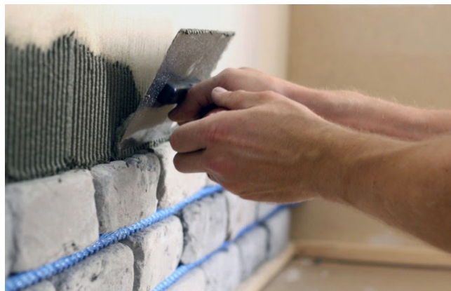
Käytä laastin levitykseen 8-9 mm piikkistä laastikampaa.
