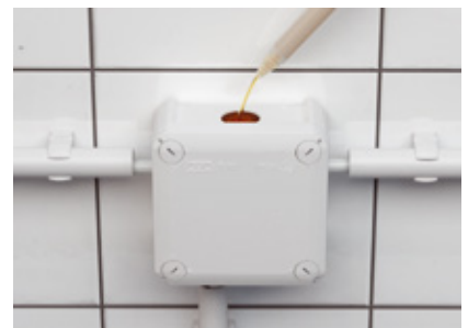
Helppokäyttöinen: Jakorasian eristäminen kaapeliihion kautta.
