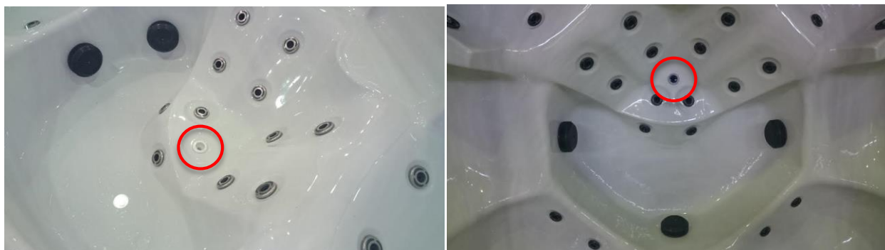
Kuva 3. Otsonisuutinpäikat 1 ja 2
