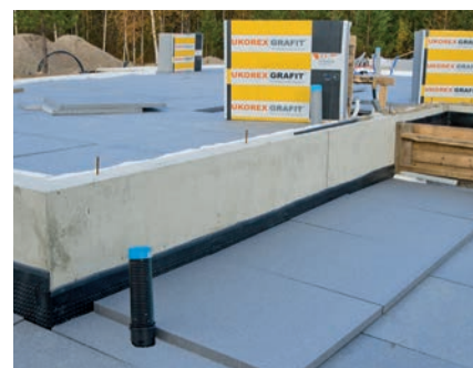
Tuulettuva ontelolaatta-alapohja, yläpuolinen eriste Betonirunko Ohutrappaus
