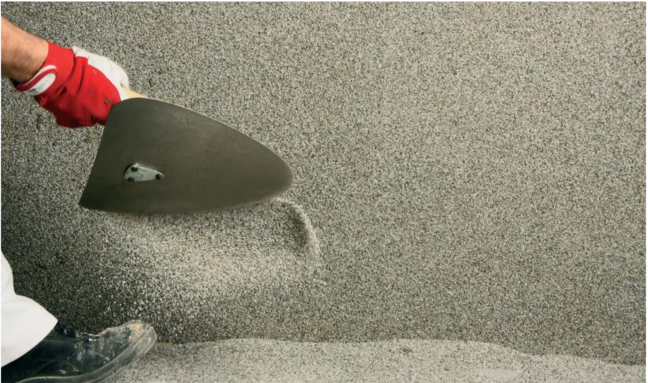
Sokkelin pinnoitus weber.vetonit HR Hienorouheella.
