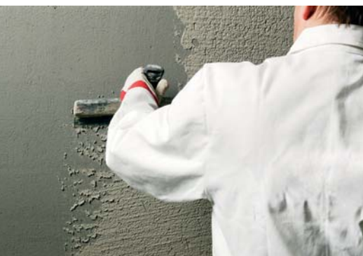
Levitä weber.vetonit SockeliPinnoite käsin teräslastalla tai koneellisesti ruiskulla. Poista ylimääräinen pinnoite teräslastalla maksimi raekoon paksuiseen kerrokseen.
