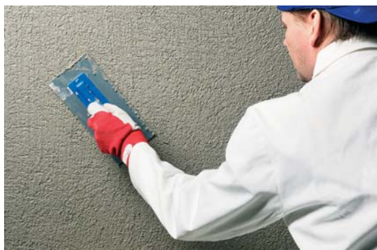
Hierrä Pinnoite heti tasaiseksi leikkaavalla muovihiertimellä. Jos hierrin tarttuu kiinni tai jälki on liettynyttä, pinnoitetta on liian paksu kerros. Tällöin voit poistaa ylimääräistä pinnoitetta teräslastalla ja hierontaa uudelleen hierontimellä. Voit jättää pinnan myös ruiskupinnaksi. Kerrospaksuudeksi hierrettäessä tulee noin 2 mm.
