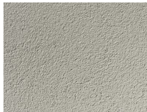
SockeliPinnoitteella hierretty pinta.
