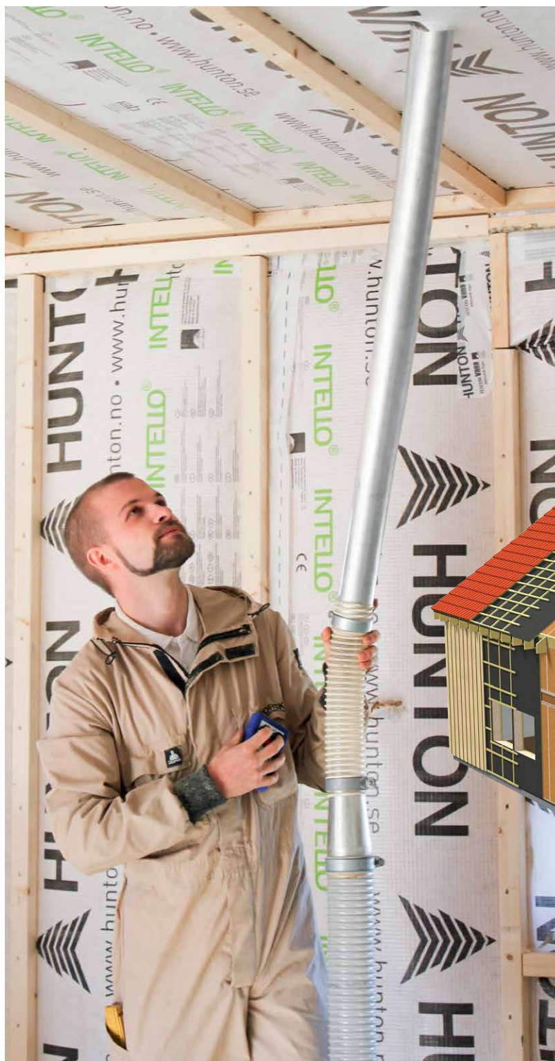
Havainnekuvassa näkyy Nativo Puukuitueristeellä puhallettu seinä.
