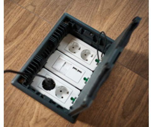
Lattiarasia L 6 moduulin asennuksessa.
