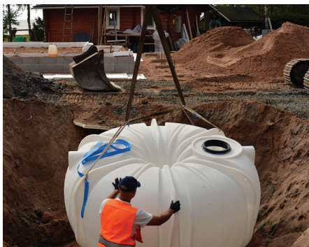
Säiliö nostetaan ankkurointikorvista liinoilla.
