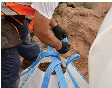
Pujoita liina täytettyjen ja säiliön viereen siirrettyjen ankkurointipussien silmukoiden läpi.
