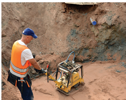
Tasoita ja tiivistä asennuskaivannon pohja huolellisesti.
