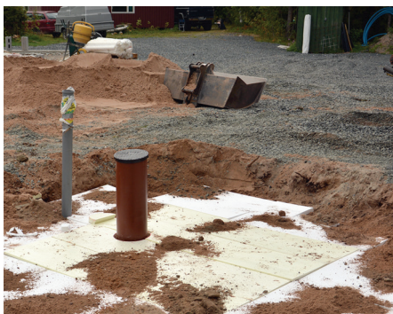
Eristä kaivanto ja viemäriputki routaeristelevyillä.
