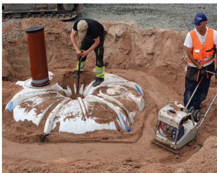
Tiivistä kaivanto 20cm kerroksissa välillä tiivistäen.
