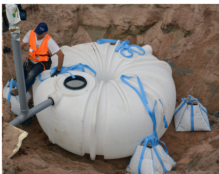
Ankkuroi umpisäiliö vähintään neljästä eri kohdasta.
