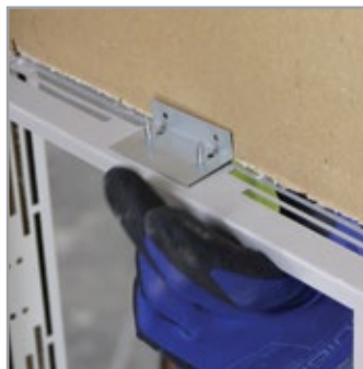
6 Kiinnitä kiinnitysprofiilit ruuvaamalla (kuva otettu seinän taustapuolelta).
