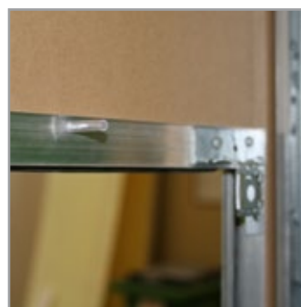
8 Suojaa kehyksen läpi tulleet ruuvit pakkauksessa olevilla tulpilla luukun huoltokäytön helpottamiseksi.
