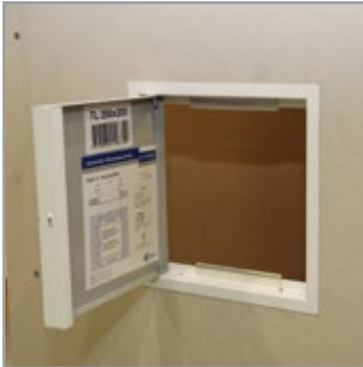
5 Kiinnitä luukku kiinnitysprofiileilla, ruuveja ei tarvita.
