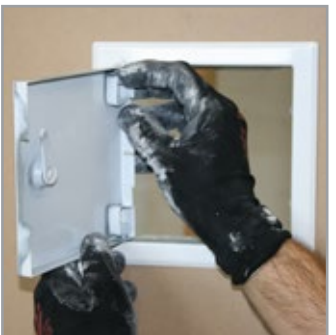
9 Asenna kansi paikoilleen kehykseen. Luukun aukeamissuunnan voi päättää tässä vaiheessa. Varmista lukon pitkäaikaistoimivuus tipalla lukkoöljyä.
