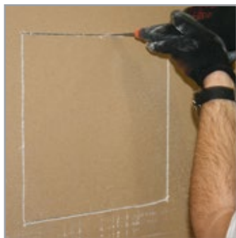
1 Mittaa ja piirrä asennusaukon koko kipsilevyyn.
