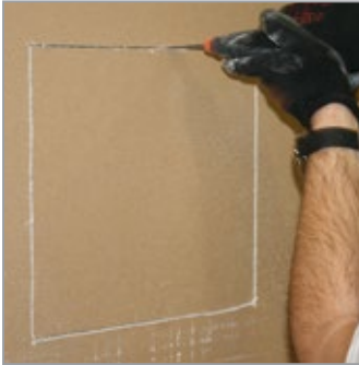
1 Mittaa ja piirrä asennusaukon koko kipsilevyyn.
