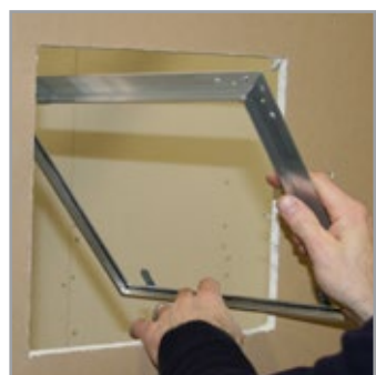
5 Työnnä kehys aukon läpi. Huomioi kehyksen vaatima asennusvara (3-5 senttiä levyn takana) rungontekovaiheessa.
