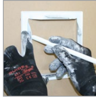
3 Piirrä asennusaukon koko kipsilevyyn. Apuna voit käyttää luukun kehystä (käännä luukku väärinpäin ja piirrä viiva kehyksen sisäreunaa pitkin).
