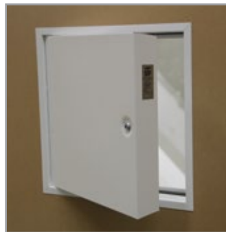
7 Asennus on valmis.
