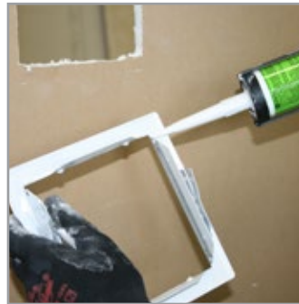
6 Voit halutessasi käyttää kiinnityksen varmistamiseksi Gyproc G 44 -asennusliimaa.
