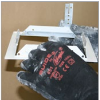
5 Nosta luukun kiinnityssiivekkeet pystyyn.
