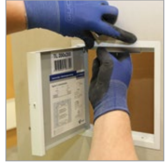
4 Luukku kiinnitetään rakenteeseen kiinnitysprofiilien avulla.
