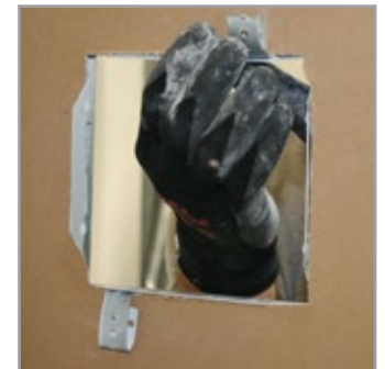
8 Taivuta kiinnityssiivekkeet kipsilevyn taakse kaksinkerroin kuvan osoittamalla tavalla.
