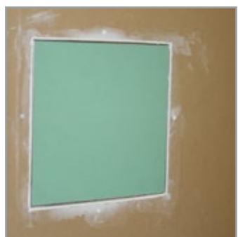
11 Asenna kansi paikalleen. Kansi maalataan irrallisena, jotta kehyksen ja kannen välinen rako ei täyty maalista.
