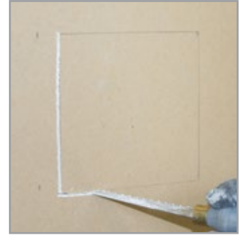
4 Sahaa merkinnän mukaan. HUOM: jos olet tehnyt viivan asennettavaa luukku apuna käyttäen, sahaa muutamia milli viivan ulkopuolelta, jotta kehys mahtuu tehtävään aukkoon.
