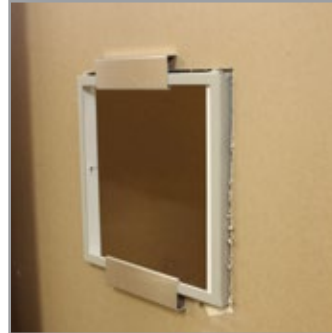
7 Valmis asennus levyn taustapuolelta kuvattuna.
