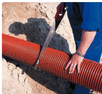
1. Putki katkaistaan kohtisuoraan ripojen välistä uraa myöten.
