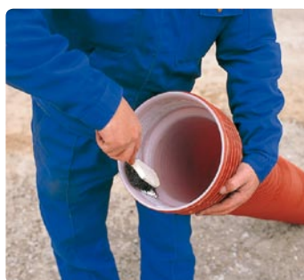
3. Liukuainetta sivellään muhvin sisäpintaan.
