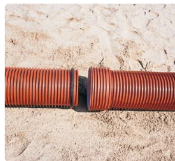
2. Tiivisterengas asennetaan pistopään toiseen uraan.
