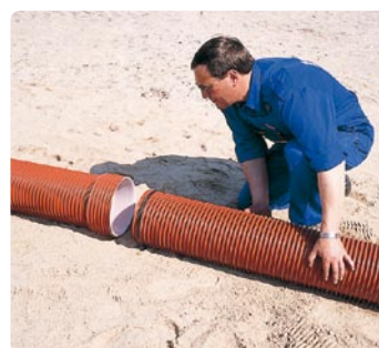
4. Muhviliitos työnnetään pohjaan asti. Putken pään ja muhvin pohjan väliin ei jää rakoa.
