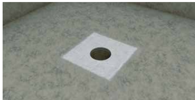
1. Poista kaivon kiristysrenkas, jätä vastatiiviste paikoilleen. Levitä SCHÖNOX HA /Casco AquaStop -vedeneristettä lattiakaivon alueelle ohut kerros tai paina Wetstop MG kaivolaippa suoraan kiinni jo pohjustettuun alustaan läpiviennin alueelle ohut kerros.
