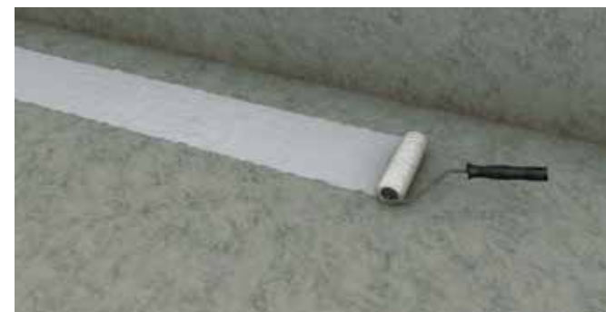
5. SCHÖNOX HA / Casco AquaStop -vedeneristeen asennus lattiaan: Levitä ensimmäinen kerros vedeneristettä telalla. Käytä nurkissa ja läpivientien ympärillä pensseliä. Telaamiseen suositellaan hyvälaatuisia tiheänukkaisia teloja. Nukan pituus n. 8 -15 mm.
