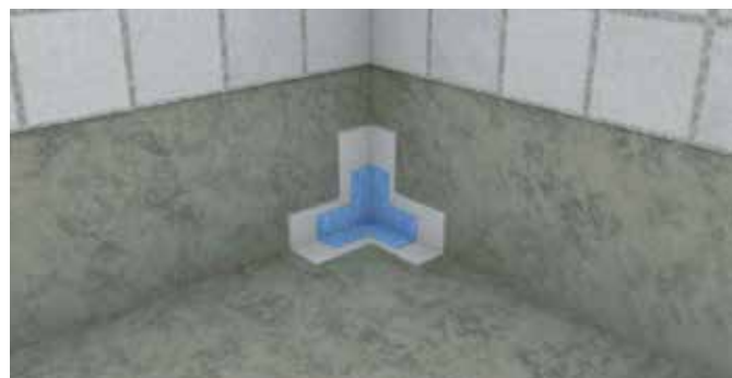
2. Paina Wetstop nurkkakappale kiinni tuoreeseen vedeneristeeseen siten, että kaikki ilma poistuu kappaleen alta. Jos nurkka ei ole täysin suorassa ja nurkkakappaleeseen syntyy pussi, pyri ohjaamaan pussi tulevan limityksen alueelle ja tee sinne viilto. Muista että vahvikekappaleiden tule limittyä ehjänä vähintään 5 cm. Mikäli käytät vedeneristysnauhaa (kuitukangas), katso leikkausohjeet viereiseltä sivulta.
