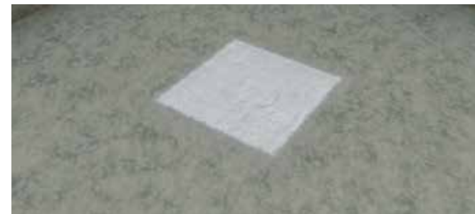
4. Levitä kerros vedeneristettä Wetstop MG -läpivientikappaleen päälle.
