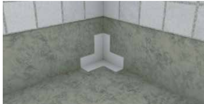
1. Levitä vedeneristettä nurkkakappaleen alueelle.
