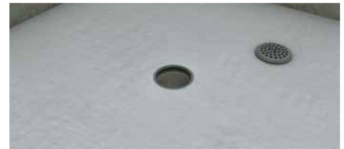
8. Tarkastuksien jälkeen leikkaa kiristysrenkaan alta näkyvä liika vahvike pois varmistuen että kiristysrenkas on edelleen pohjassa.
