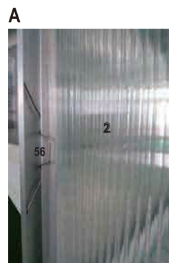
bild på fastsättning av 4 mm takpanel
