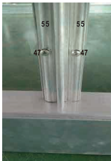
kuva 4 mm:n kattopaneelin kiinnityksestä
