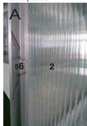
Käytä klipsiä numero 56 kattopaneelin kiinnittämiseen
