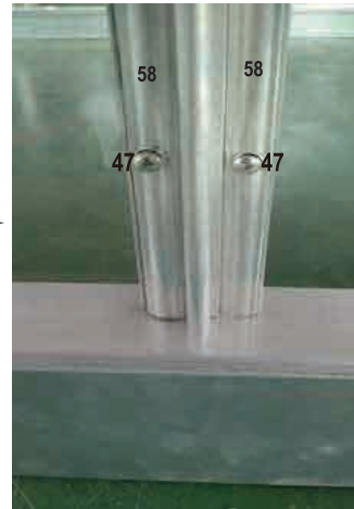
kuva läpinäkyvän seinäpaneelin kiinnityksestä
