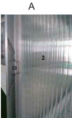
bild på fastsättning av 4 mm takpanel
