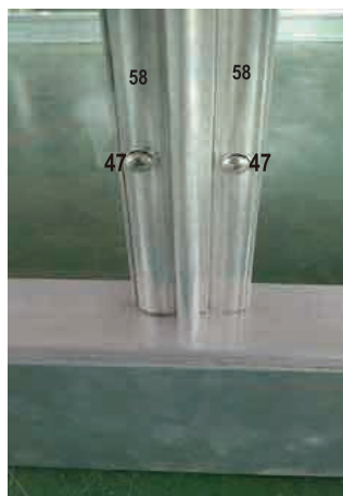
kuva läpinäkyvän seinäpaneelin kiinnityksestä kiinnityksestä sen päälle ruuvattavan alumiinilistan avulla.
