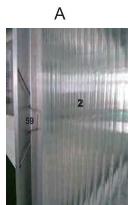
kuva 4 mm:n kattopaneelin kiinnityksestä
