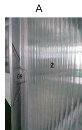
bild på fastsättning av 4 mm takpanel
