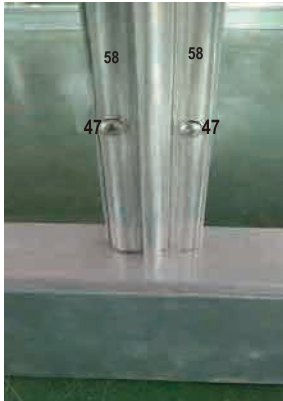
bilde av montering av den gjennomsiktige veggplaten
