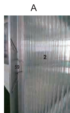
foto 4 mm katusepaneeli kinnitamisest
