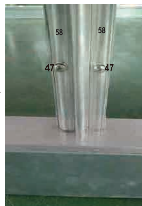
foto läbipaistva seinapaneeli kinnitamisest
