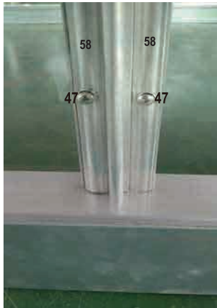
bild på fastsättning av genomskinlig takpanel
