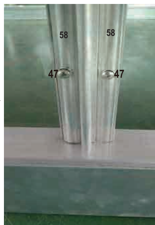
bild på fastsättning av genomskinlig takpanel
