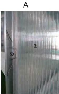
bilde av montering av 4 mm takplate
