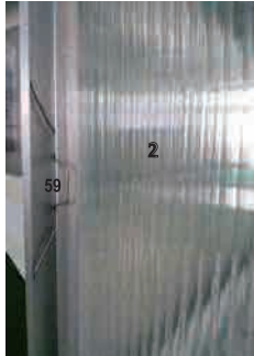
bilde av montering av 4 mm takplate
