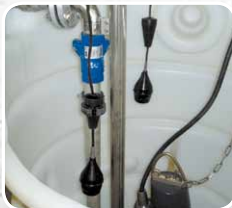
SEG-pumpun pintakytkimet reagoivat vedenpinnan vaihteluun ja ohjaavat pumpun toimintaa tarpeen mukaan.
