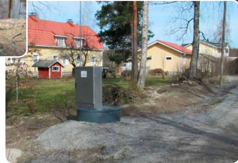
Polar 1400-2 -linjakpumppaamossa on 2-osainen eristetty kansi, jonka toisella puoliskolla on kaapeliläpiviennit ohjauskeskukselle. Iso huoltoluukku helpottaa huoltotoimenpiteitä.
