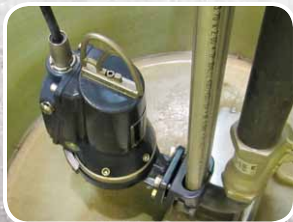
SEG-pumpun pintakytkimet reagoivat vedenpinnan vaihteluun ja ohjaavat pumpun toimintaa tarpeen mukaan.
