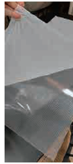
Valkoinen suojakalvo 4,0 mm kattopaneeleissa osoittaa paneelin UV-suojatun puolen.
