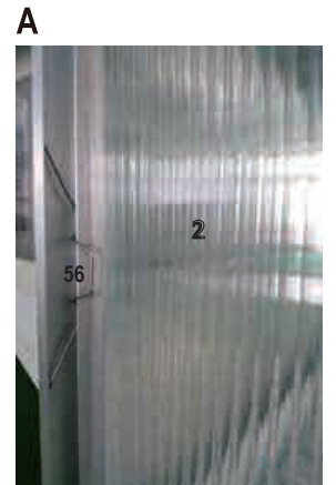
kuva 4 mm:n kattopaneelin kiinnityksestä Kattopaneelit kiinnitetään runkoon osan 56 avulla
