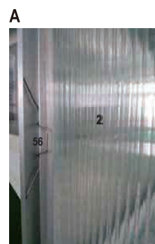
bilde av montering av 4 mm takplate
