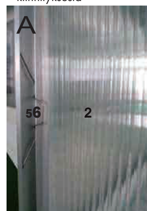
Käytä klipsiä numero 56 kattopaneelin kiinnittämiseen
