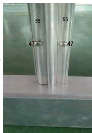
bild på fastsättning av genomskinlig takpanel
