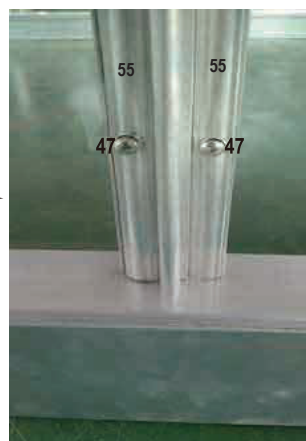
foto läbipaistva seinapaneeli kinnitamisest
