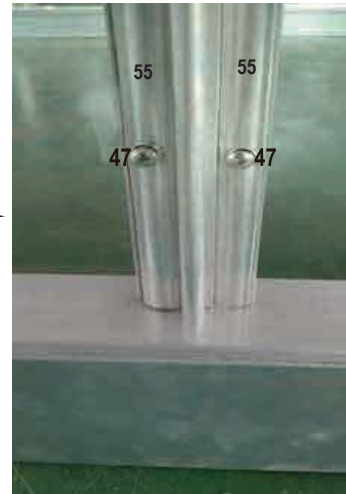
kuva läpinäkyvän seinäpaneelin kiinnityksestä sen päälle ruuvattavan alumiinilistan avulla.
