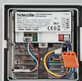
Säädä valomäärä ja värilämpötila DIP-kytkimillä
