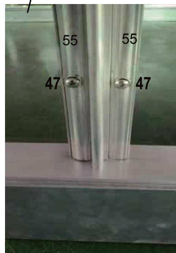
foto läbipaistva seinapaneeli kinnitamisest
