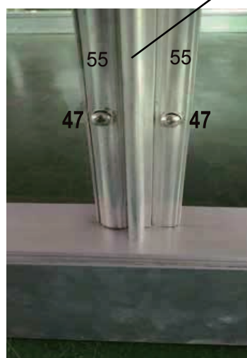
bild på fastsättning av genomskinlig takpanel
