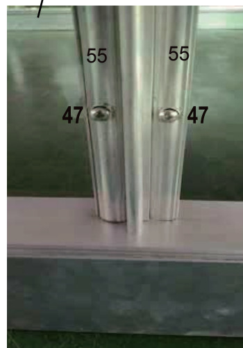
bilde av montering av den gjennomsiktige veggplaten
