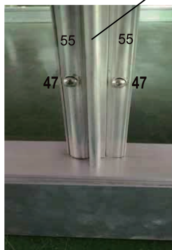
bilde av montering av den gjennomsiktige veggplaten
