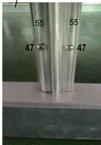
bild på fastsättning av genomskinlig takpanel
