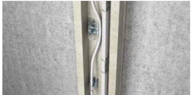
Kaapectien kiinnitys pystyasennuksessa
