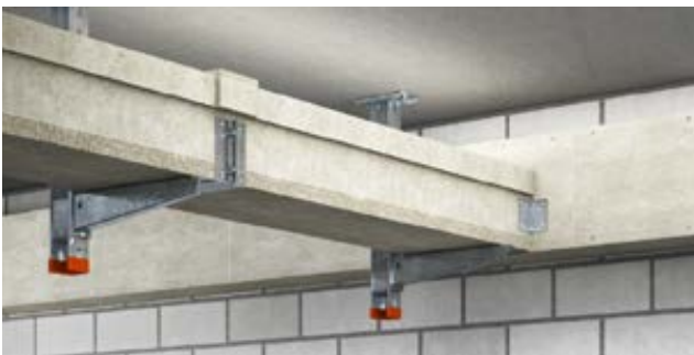
Liitäntä PLCD palosuojakanavaan
