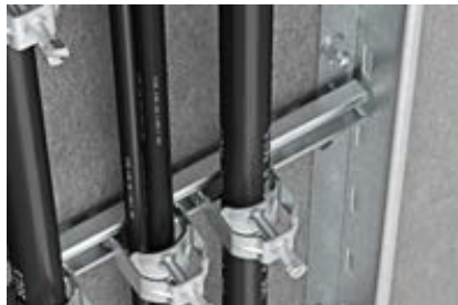
Nousutikkaana käytettäessä tikashylly voidaan kiinnittää suoraan seinään profiilissa olevista rei'istä. Pienaa sopiva kaarikiinnike tyyppi 2056.
