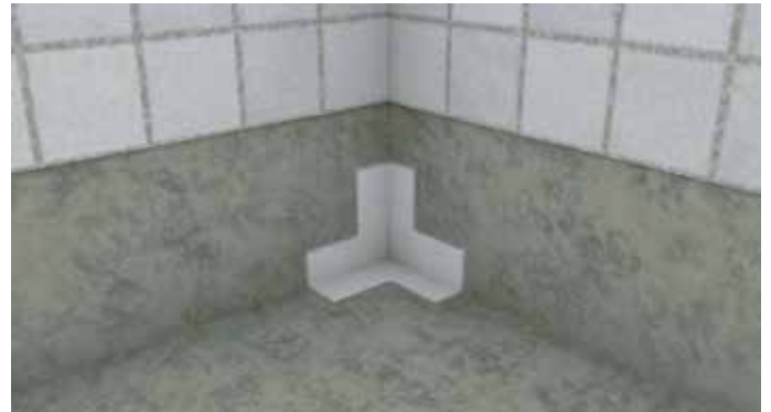
3. Levitä vedeneristettä nurkkakappaleen päälle.
