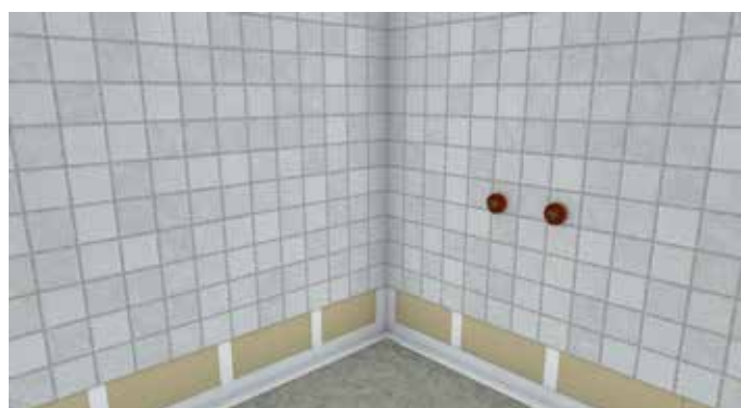
6. Jatka kunnes kaikki liitoskohdat on vahvennettu/tiivistetty.
