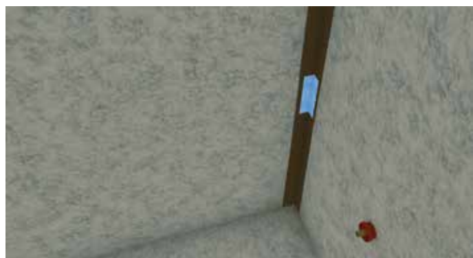
1. Levitä SCHÖNOX 2K-DS RAPID -vedeneristettä alueelle, johon vahvikenauha asennetaan. Paina WetStop KL -vahvikenauha vedeneristeeseen niin, että kaikki ilma poistuu nauhan alta. Tarkista myös, että nauha kostuu riittävästi. Levitä lopuksi vedeneristettä nauhan päälle.
