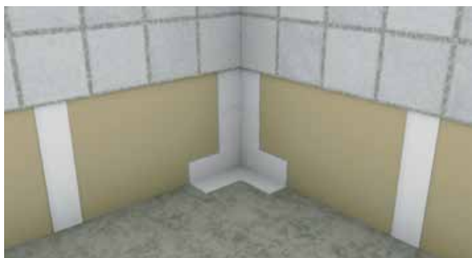
1. Levitä vedeneristettä nurkkakappaleen alueelle.
