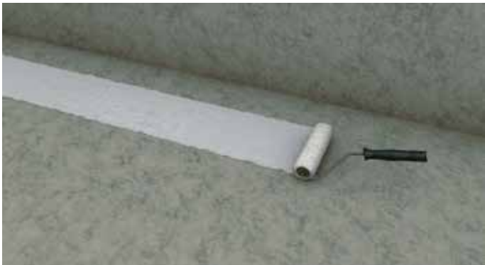
5. SCHÖNOX HA / HA PRO -vedeneristeen asennus lattiaan: Levitä ensimmäinen kerros vedeneristettä telalla. Käytä nurkissa ja läpivientien ympärillä pensseliä. Telaamiseen suositellaan hyvälaatuisia tiheänuk-kaisia teloja. Nukan pituus n. 8 -15 mm.
