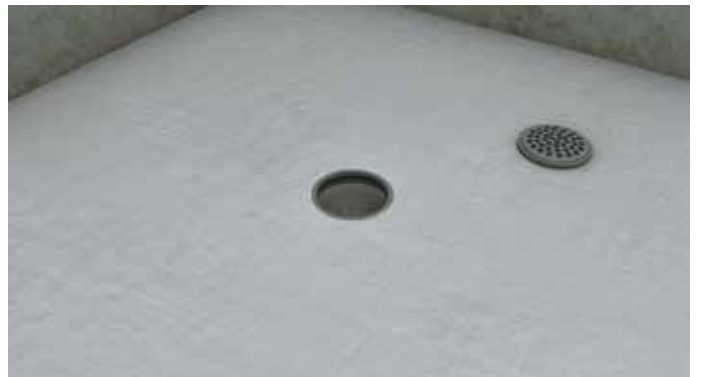
8. Tarkastuksien jälkeen leikkaa kiristysrenkaan alta näkyvä liika vahvike pois varmistuen että kiristysrengas on edelleen pohjassa.
