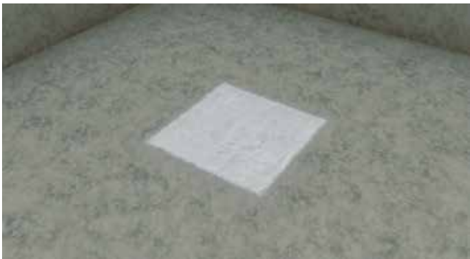
4. Levitä kerros vedeneristettä Wetstop MG -läpivientikappaleen päälle.
