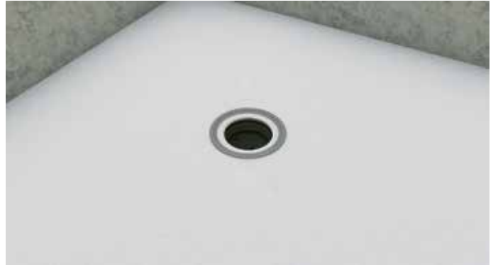
7. Paina kiristysrengas kansineen paikoilleen niin syvälle kuin se on mahdollista ja varmistu, ettei kiristysrengas nouse jännityksen aiheuttamana. (suurennä kaivokappaleen reikää).
