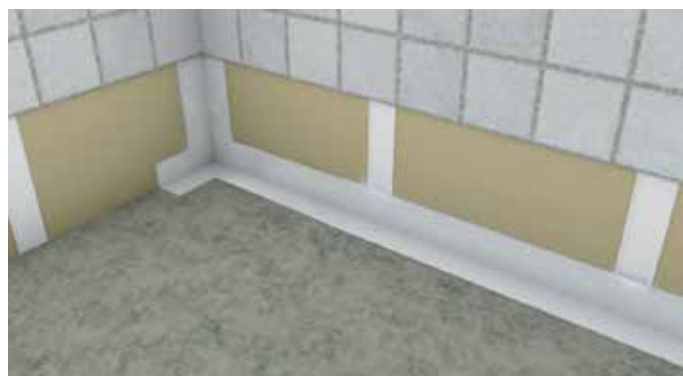
4. Levitä vedeneristettä vedeneristysnauhan alueelle lattian ja seinän liitoskohtaan.
