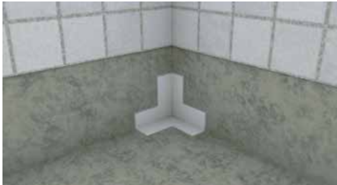
1. Levitä vedeneristettä nurkkakappaleen alueelle.
