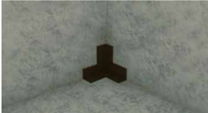
1. Levitä vedeneristettä nurkkakappaleen alueelle.
