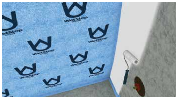
4. Levitä SCHÖNOX iFIX -vedeneristeliimaa telaamalla yhden vedeneristevuodon kokoiselle alueelle.
