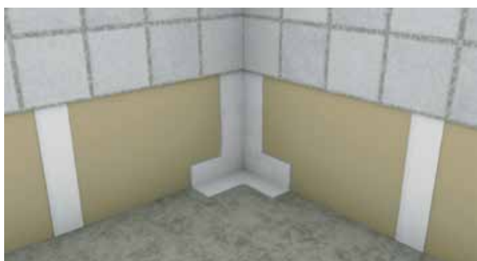
3. Vedeneristeenauha käsitellään SCHÖNOX HA -vedeneristeellä.
