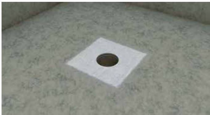
1. Poista kaivon kiristysrenkas, jätä vastatiiviste paikoilleen. Kaivokappaleen asentamisessa voidaan käyttää kahta eri tapaa: Wetstop MG kaivokappale voidaan painaa suoraan huolellisesti pohjustettuun ja kuivuneen alustan päälle tai pohjustetun alustan päälle voidaan levittää hyvin ohut kerros vedeneristettä.
