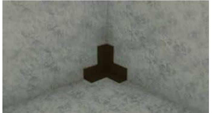
3. Levitä vedeneristettä nurkkakappaleen päälle.
