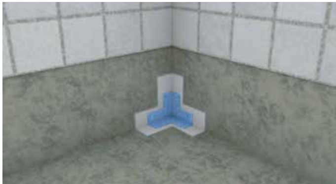
2. Paina Wetstop nurkkakappale kiinni tuoreeseen vedeneristeeseen siten, että kaikki ilma poistuu kappaleen alta. Jos nurkka ei ole täysin suorassa ja nurkkakappaleeseen syntyy pussi, pyri ohjaamaan pussi tulevan limityksen alueelle ja tee sinne viilto. Muista että vahvikekappaleiden tule limittyä ehjänä vähintään 5 cm. Mikäli käytät vedeneristysnauhaa (kuitukangas), katso leikkausohjeet viereiseltä sivulta.
