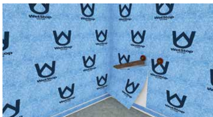
5. Paina vuota kiinni tuoreeseen iFIX-vedeneristeliimaan. Poista huolellisesti kaikki ilma kalvon alta. Ylipursuava liima levitetään alueelle, jossa kalvot ovat limittyneet min. 5 cm. Mahdolliset putkiläpiviennit leikataan tässä vaiheessa läpi kalvosta ilman kauluksen muotoilua.
