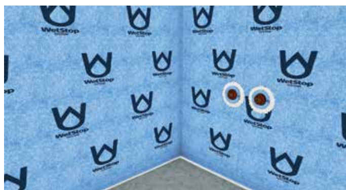
6. Levitä SCHÖNOX iFIX -vedeneristeliimaa putkiläpivientien alueelle. Paina sopivan kokoiset WetStop C -läpivientikappaleet paikoilleen ja poista kaikki ilma kappaleiden alta.
